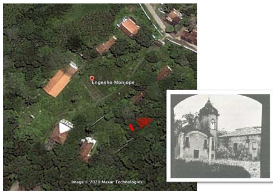
Figura 17: Localização do pórtico através de visada de fotografia de Julien Mendel em 1937. Imagem modificada do Google Earth.
