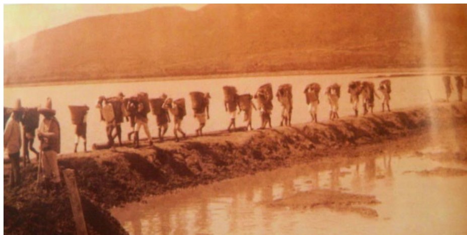
Figura 4. Construcción de un Albarradón en Ecatepec a principios del siglo XX (Foto Archivo Histórico de la Casa de Morelos).
