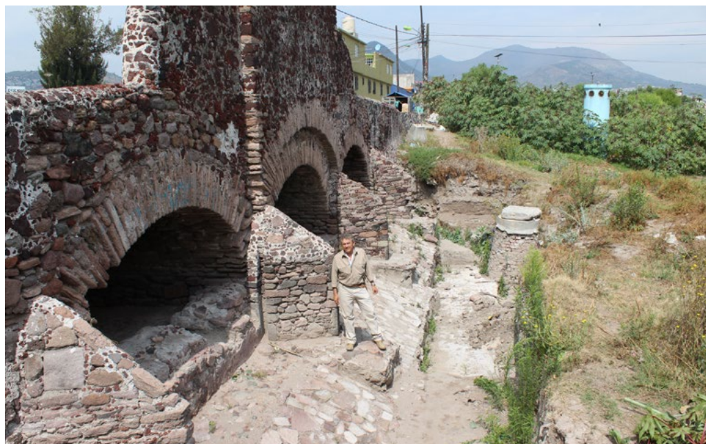
Figura 14. Vista de la compuerta tripartita en Casa de Morelos.
