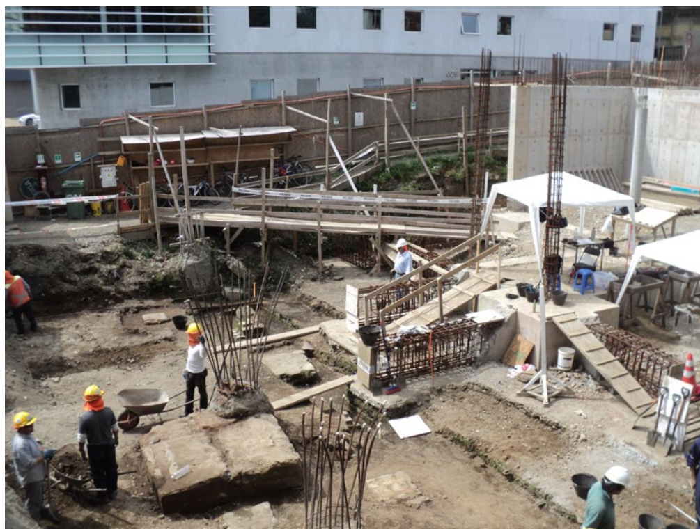
Figura 3. Sitio CRV durante la etapa de excavación, se distingue el nivel de intervenciones producto de encontrarse en un área en construcción.
